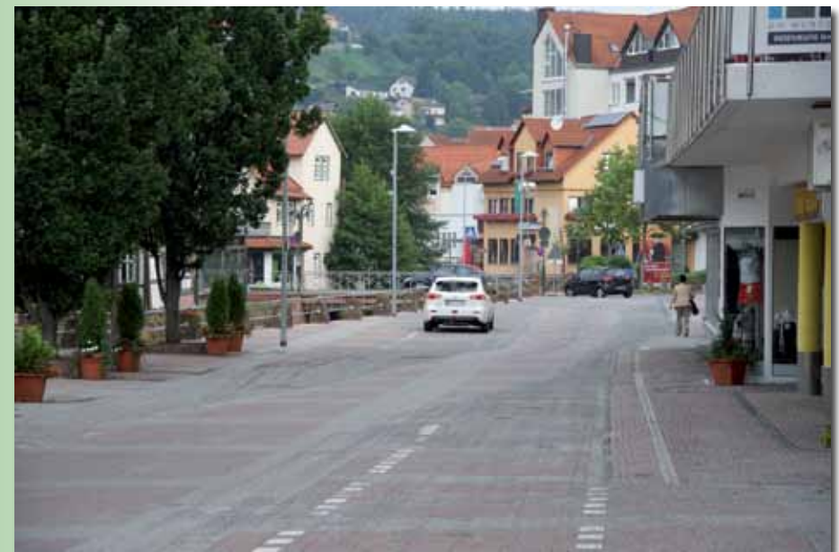
Barrierefrei gestaltet wurde der untere Abschnitt der Hauptstraße in Erbach.
