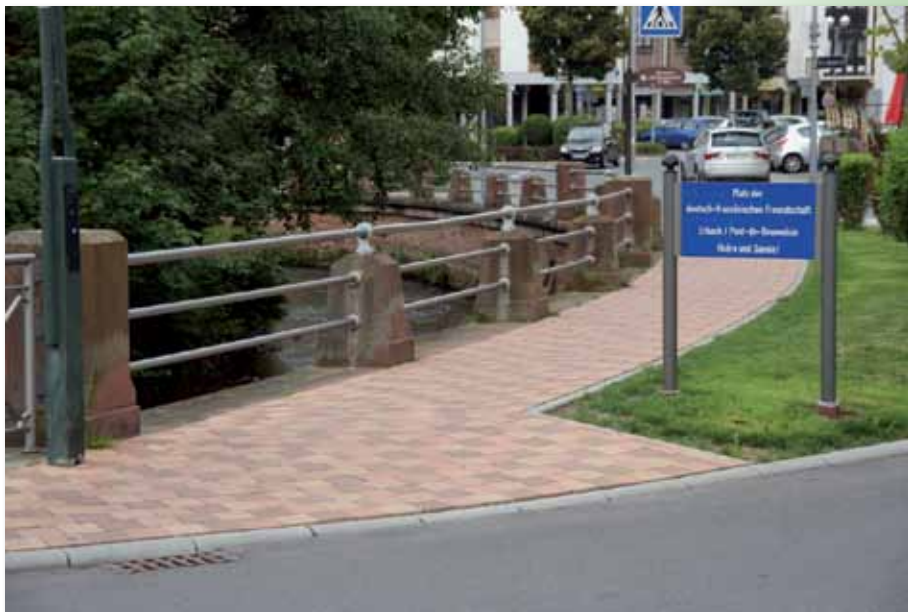
Mit abgesektem Bordstein behindertenfreundlich gestaltet wurde der Platz der Republik.
