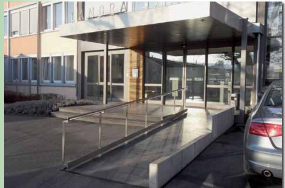
Treppenaufgang Verwaltung mit Doppelgeländer und Stufenmarkierung
